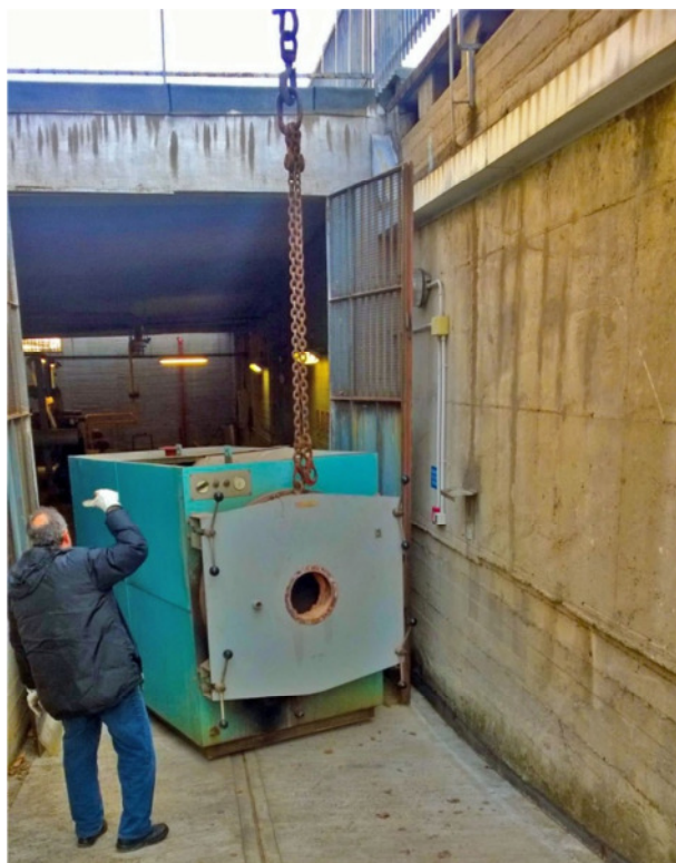
Rimozione del vecchio generatore di calore
