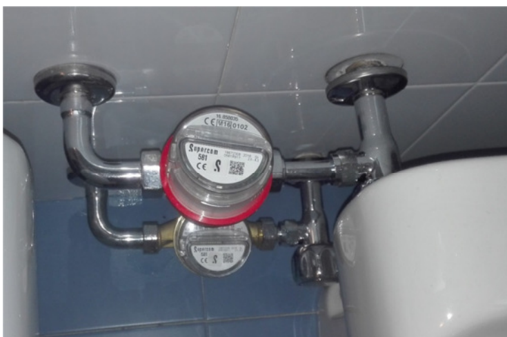
Contatore volumetrici per acqua fredda e calda sanitaria dotati di modulo radio per la trasmissione del consumo automatica
