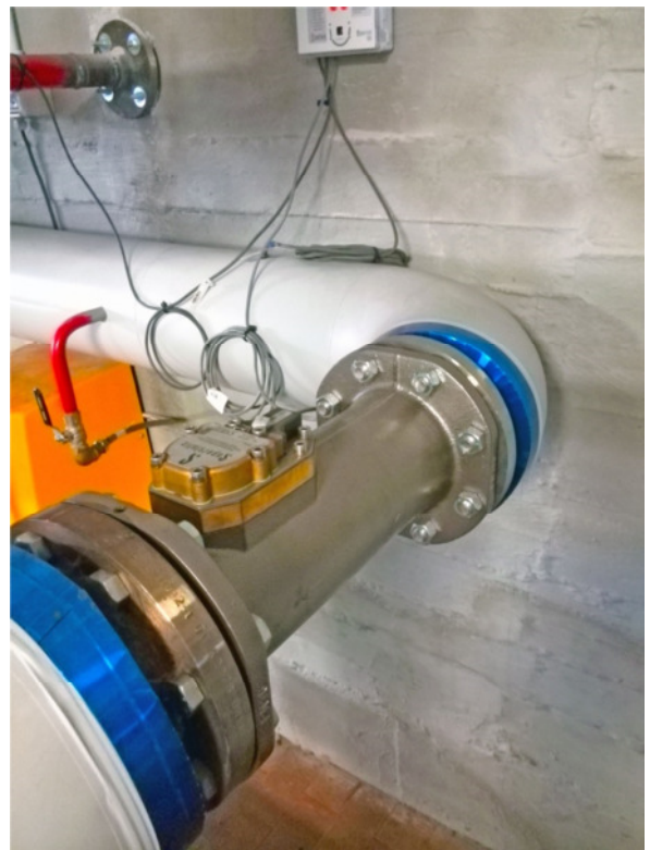
Contatore volumetrici per acqua fredda e calda sanitaria dotati di modulo radio per la trasmissione del consumo automatica
