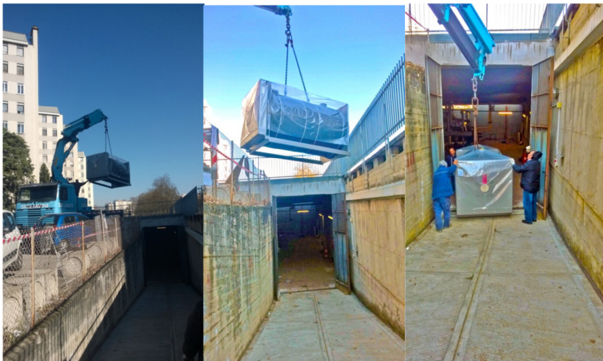
Inserimento del nuovo generatore di calore in centrale termica
